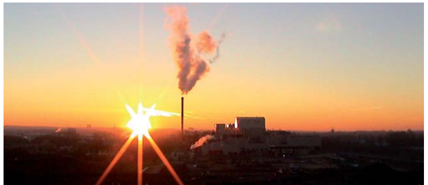
In Weurt betreibt ARN eine Verbrennungsanlage auf der Basis hochkalorischen Materials.
