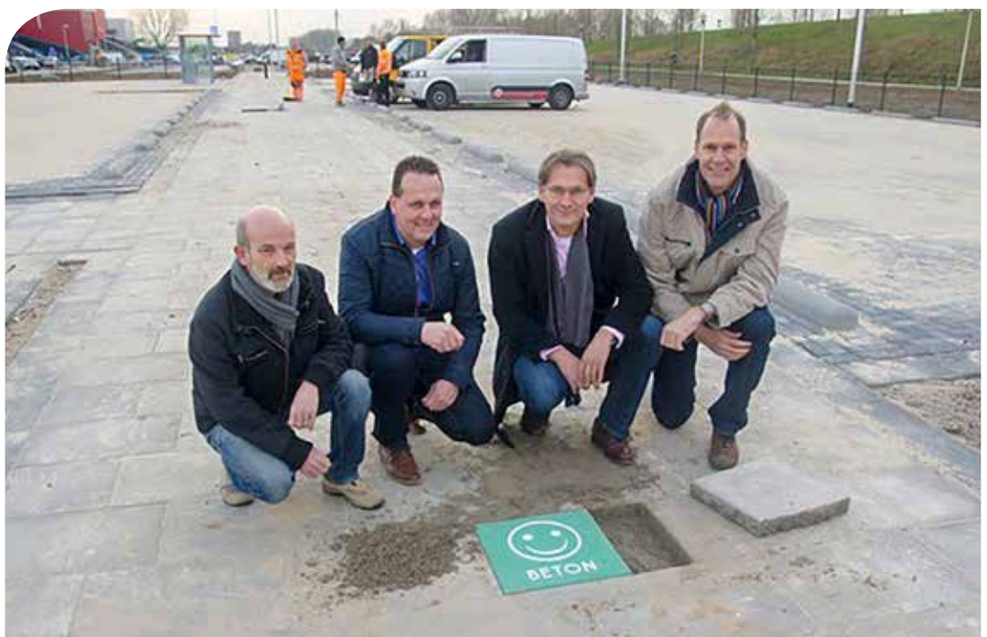
Civieltechnici van de gemeente Nijmegen met vertegenwoordigers van het Netwerk Betonketen Arnhem-Nijmegen tijdens het eerste duurzaam betonproject in Nijmegen bij de bioscoop Cinemec. De groene tegel en de andere eromheen zijn gemaakt met bodemas.
