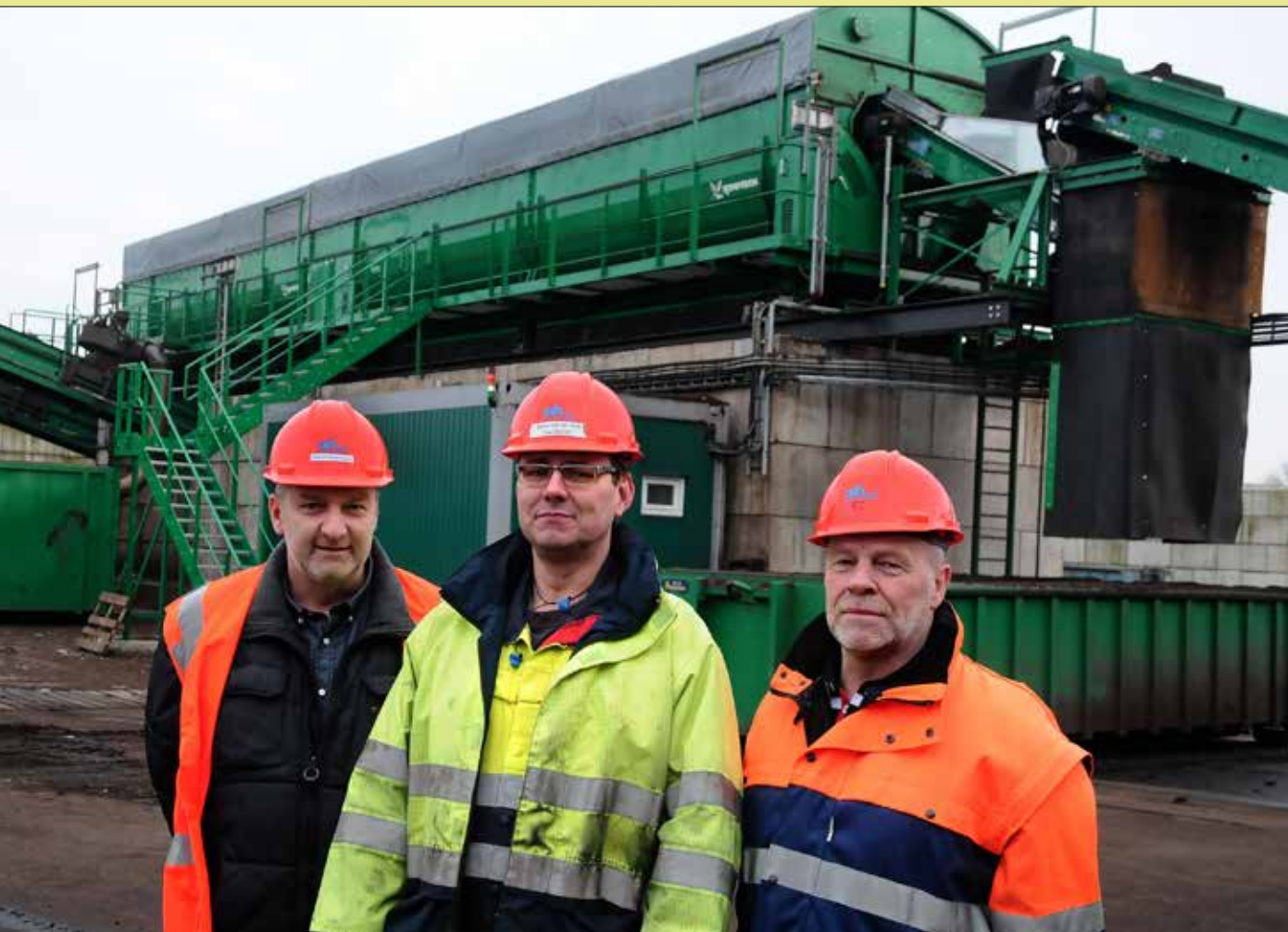
v.l.n.r. Marco Boerboom, Marco van den Hurk en Peter Drewes met op de achtergrond een deel van de Biogasinstallatie.
