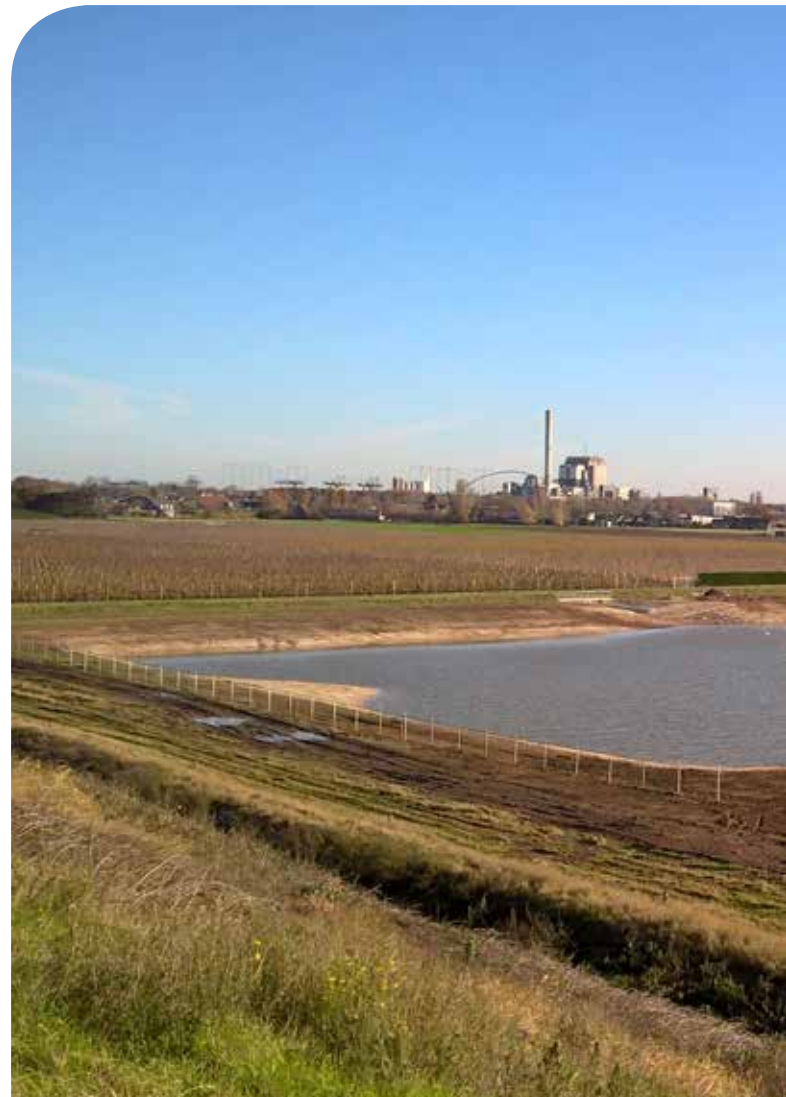
Waterberging in aanleg.
