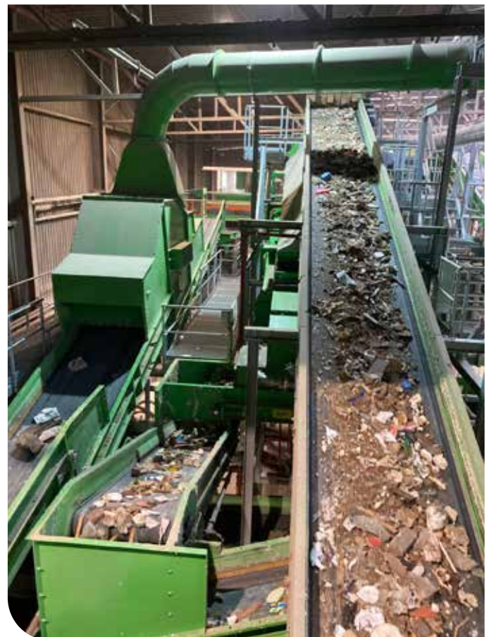
De installatie in Son kan jaarlijks 215.000 ton ongesorteerd bouw- en sloopafval scheiden in 22 verschillende materiaalstromen.
