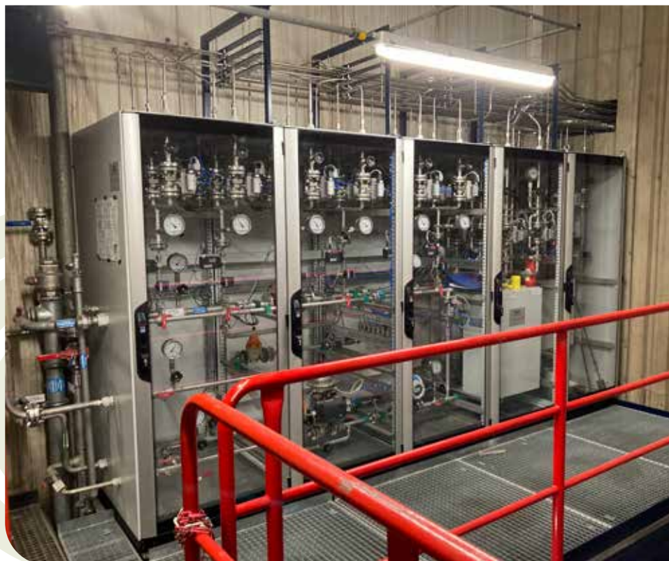
Het vergt heel wat regeltechniek om vierentwintig injectiepunten voor ammonia afzonderlijk te bedienen.
