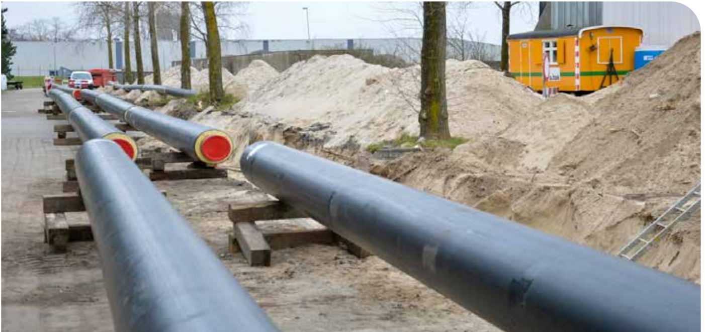
Aanleg van het warmtenet voor de Nijmeegse wijk Waalsprong.
