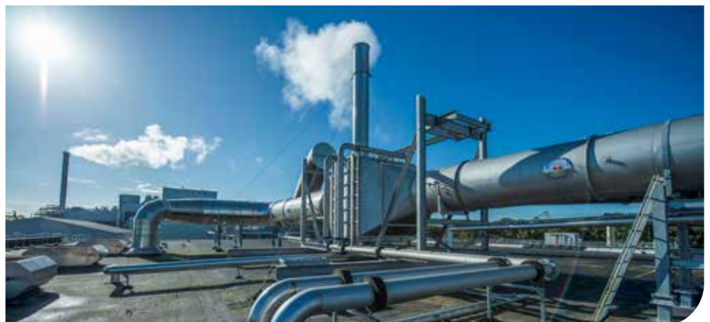
De schoorsteen van de BGI zal nog tien meter worden verhoogd tot een uitblaashoogte van veertig meter.
