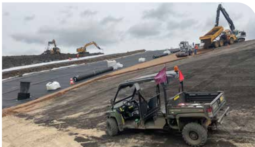
De eindafdichting in de maak. De vijf deklagen zijn van rechts naar links zichtbaar: bodemassen (donkerbruin), bentoniet (lichtbruin), kunststoffolie (zwart), drainagematten (wit) en afdekgrond (bruin).
