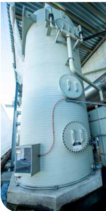
De zure wasser die ammoniak ('stikstof') uit de compostlucht verwijderd.
