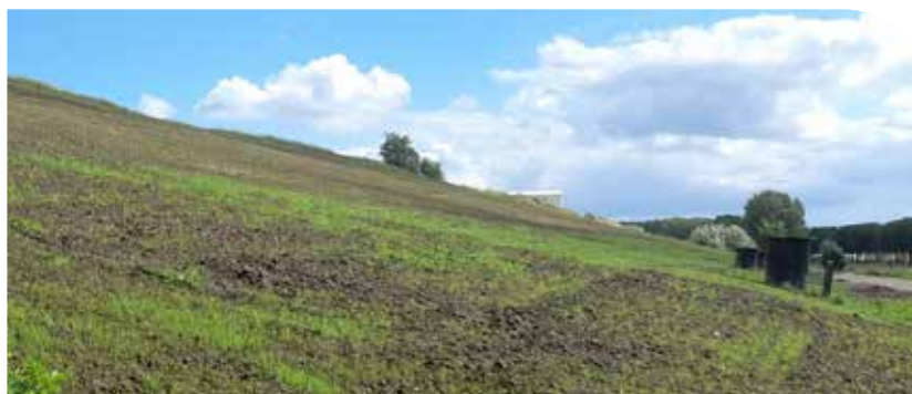
Inmiddels is het talud met gras ingezaaid.
