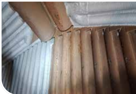
Warmtewisselaars in de ketel worden voorzien van een nieuwe coating.
