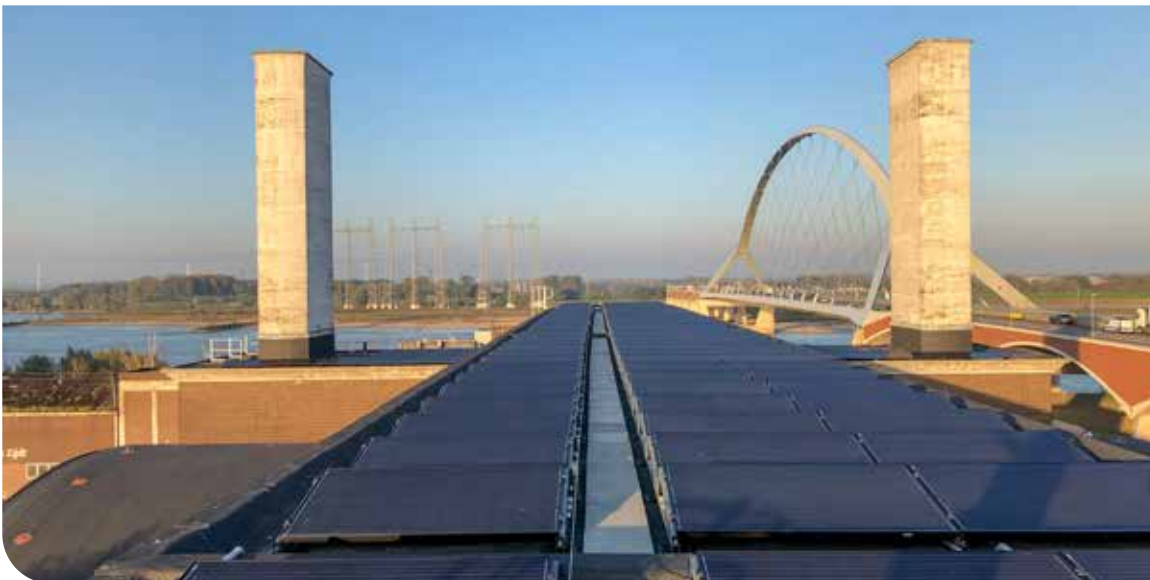
Sinds 2018 liggen op het dak van de Cultuurspinnerij De Vasim 484 zonnepanelen
